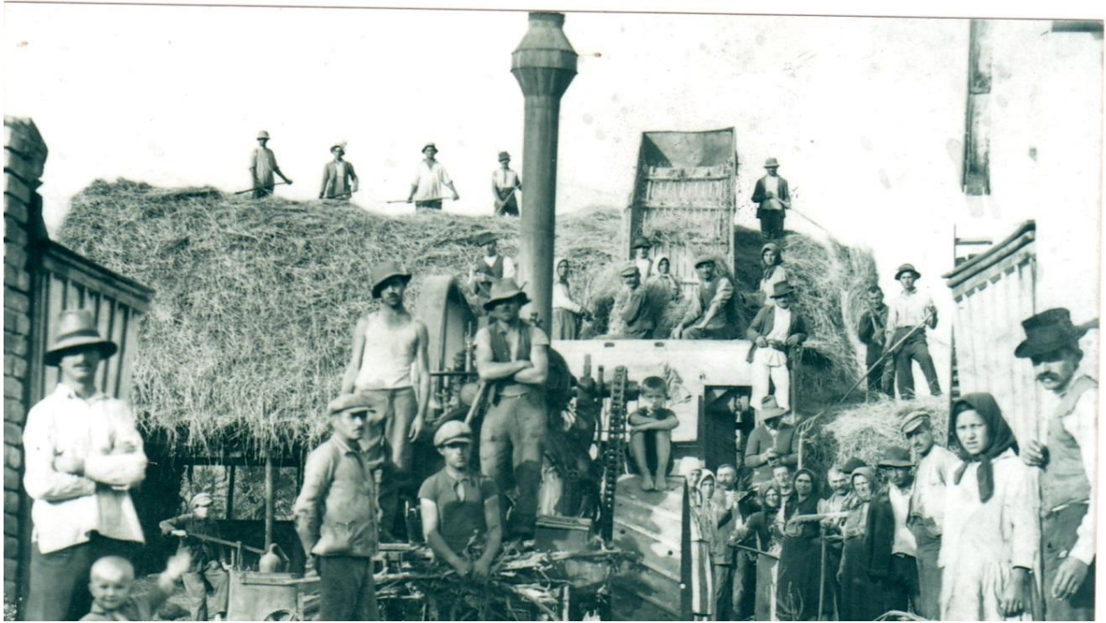
Eine Mramoraker Dreschmaschine mit der ganzen Mannschaft. Im Vordergrund ist die Dampfmaschine, in der Mitte der Dreschkasten und dahinter der Elevator ganz hinten eine stattliche Strohrischt. Leider kann ich keine näheren Angaben machen. Es war eine harte Arbeit!!
